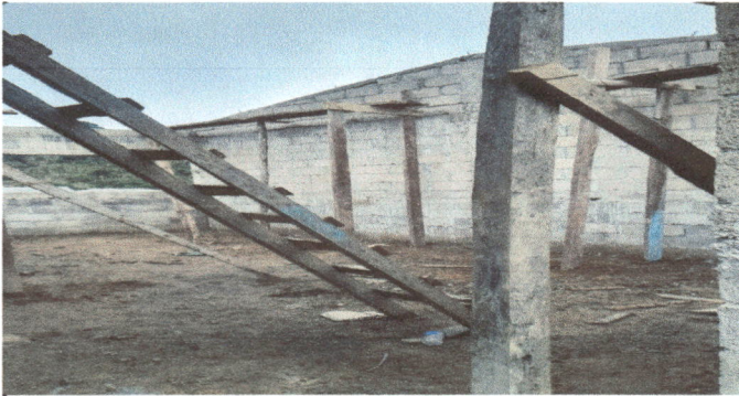
Foto: cambio de techo de madera a galvanizada.
