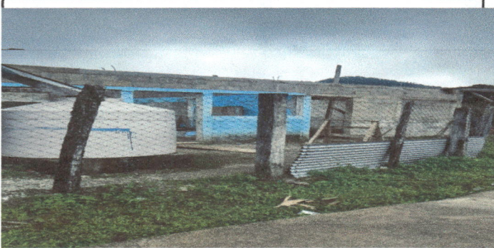
Foto 3: Cambio de lamina a troquedada.
