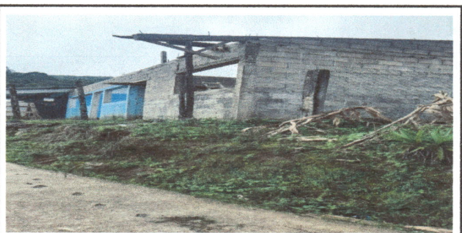
Foto 6: repello de las paredes.
