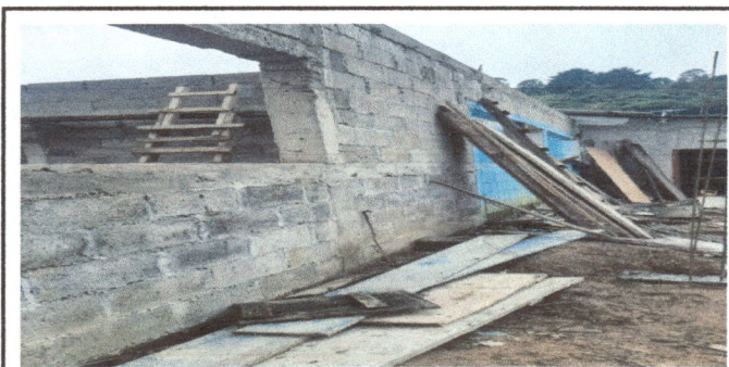
Foto 5: ampliacion de altura de pared.
